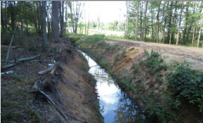
Figure 10. Ruisseau partiellement aménagé
